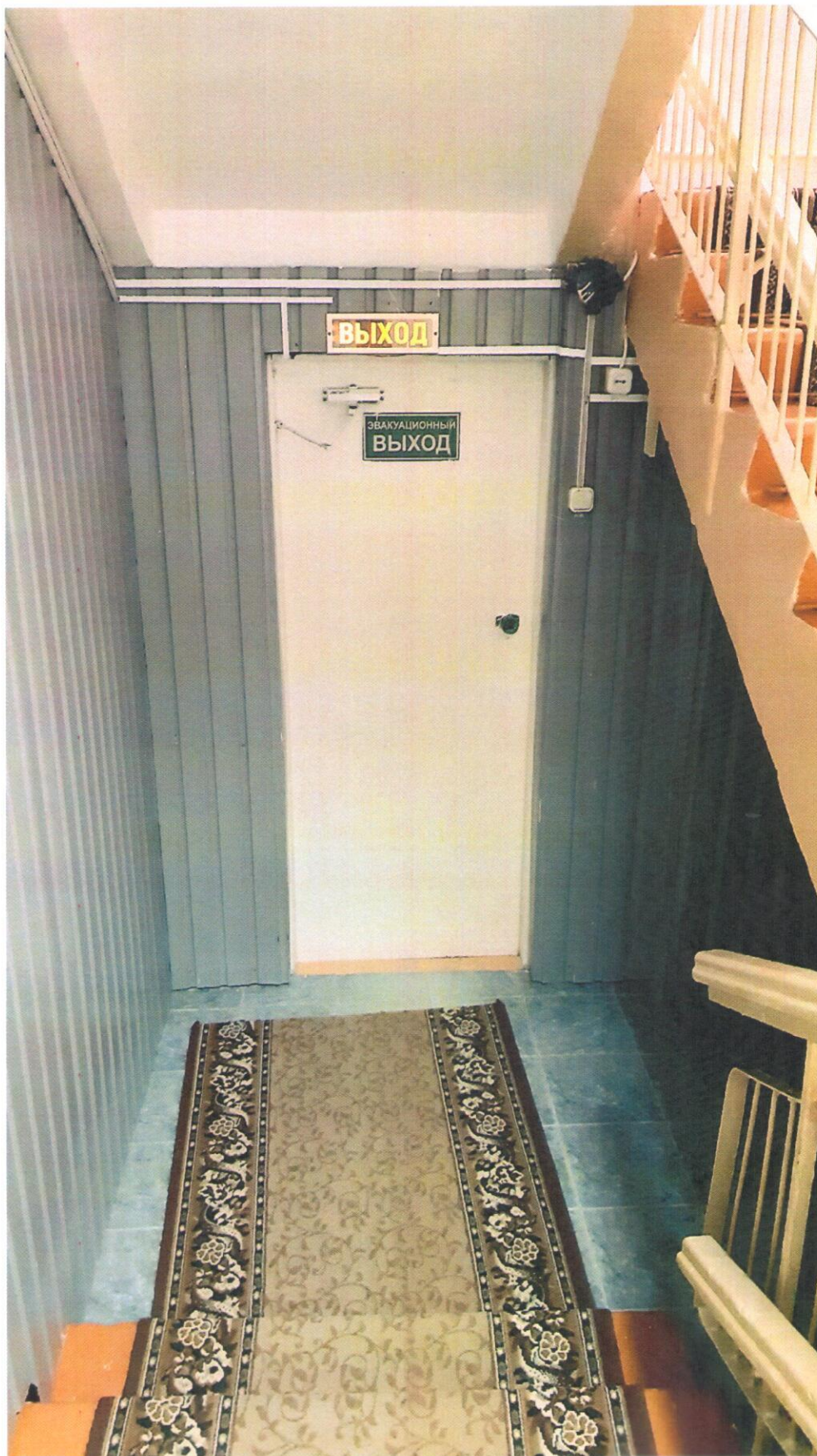
Фото 14. Дверь. Пути эвакуации
