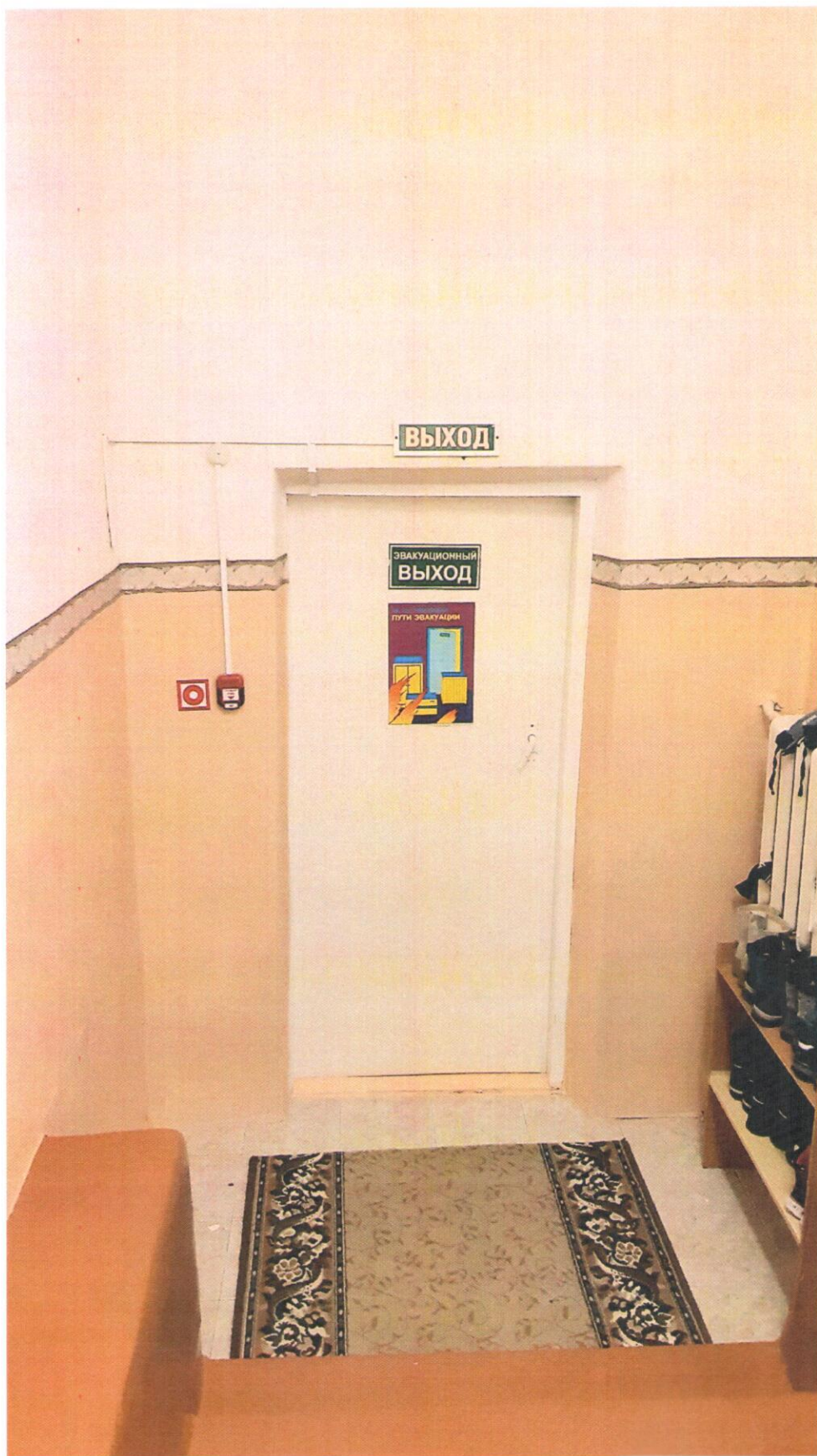
Фото 15. Дверь. Пути эвакуации
